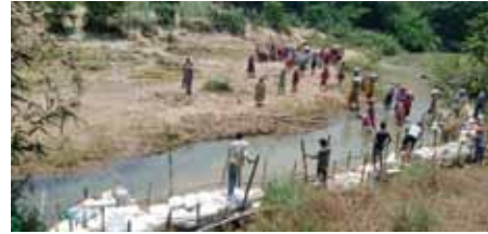
चित्र: हरियाली समूहले स्थानीय स्रोत र गौरिगंगा नगरपालिका-११ वडाबाट प्राप्त बोरा प्रयोग गरी लिक्मा नदीको अर्को किनारमा थप २०० मिटर लामो जैविक तटबन्धन निर्माण गर्‍यो ।
